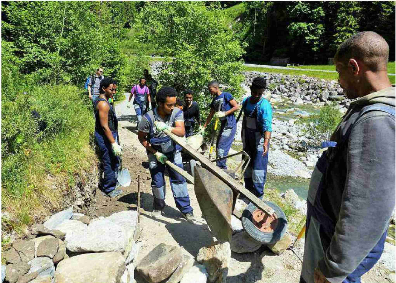
In Horboden verbreitern Asylbewerber den Talwanderweg und erstellen eine Trockenmauer.
