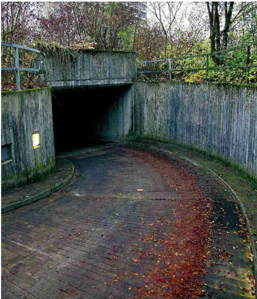
Neben dem unterirdischen Operationssaal des Bürgerspitals werden die Asylbewerber einquartiert.
