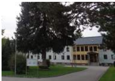
Structure de premier accueil de Thalham (Autriche)
