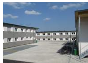
Abri provisoire à Löffingen (Bade-Wurtemberg, Allemagne)
